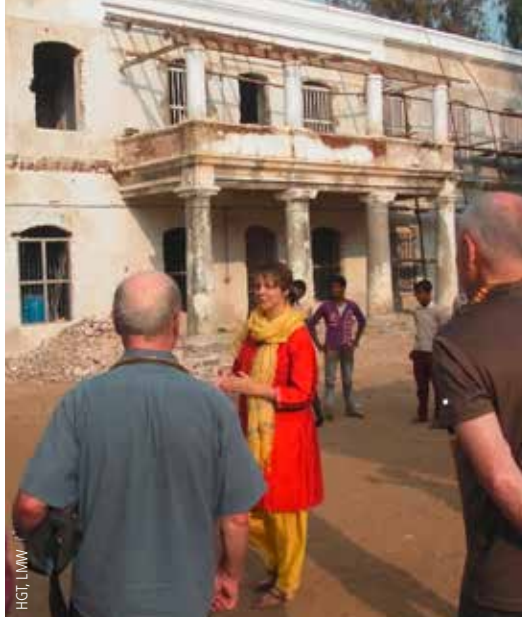
Die Restaurierungsarbeiten am Ziegenbalghaus in Tranquebar sind abgeschlossen. Am 15. Juli 2017 wurde das Museum eingeweiht.
