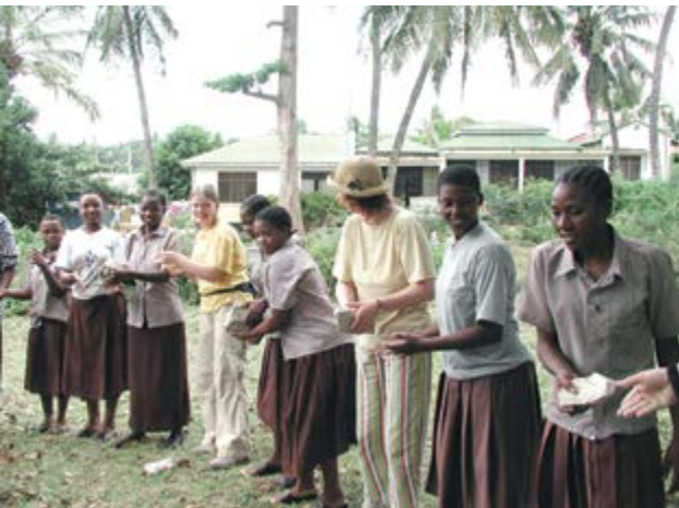
Gemeinsames Bauen am Fundament für einen neuen Raum des Kindergartens: Kisosora, 2007.
